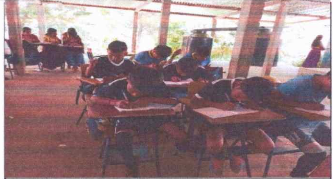
4 evidencia de como reciben clases los estudiantes, a lo cual es un riesgo para los estudiantes, debido que se encuentra en malas condiciones
