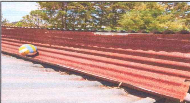
Foto 3: Sustitución de Canales para sistema de captación de agua
