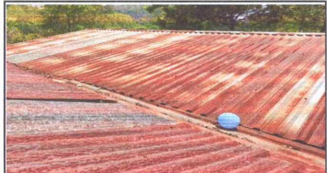
Foto 2: Vista frontal del establecimiento, que es necesario la sustitución de laminas y capotes
