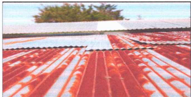
Foto 6 Sustitucion de láminas de la escuela grande y tornillos.
