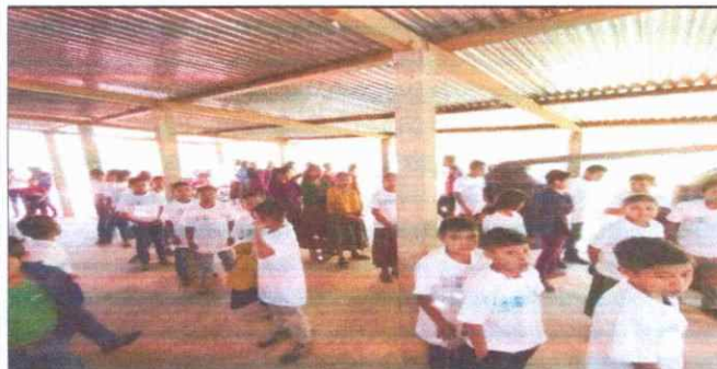
Foto 5 Los alumnos de la Escuela de San Antonio I, hacen sus actividades cívicas incomodas, por las columnas de la galera
