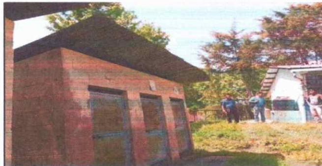
Foto 5: sustitucion de laminas de letrinas
